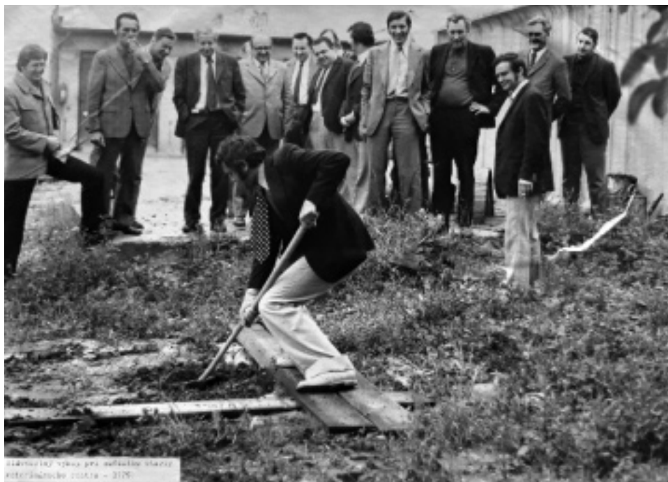
Slávnostný výkop pri začiatku stavby veterinárneho centra v Bratislave ( ÚŠVÚ, ŠVS), 1975
