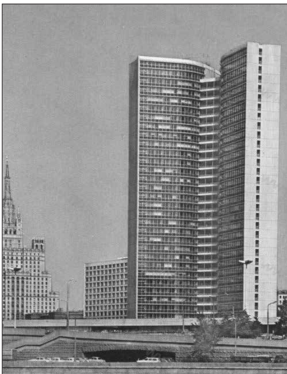
Budova RVHP Moskva
