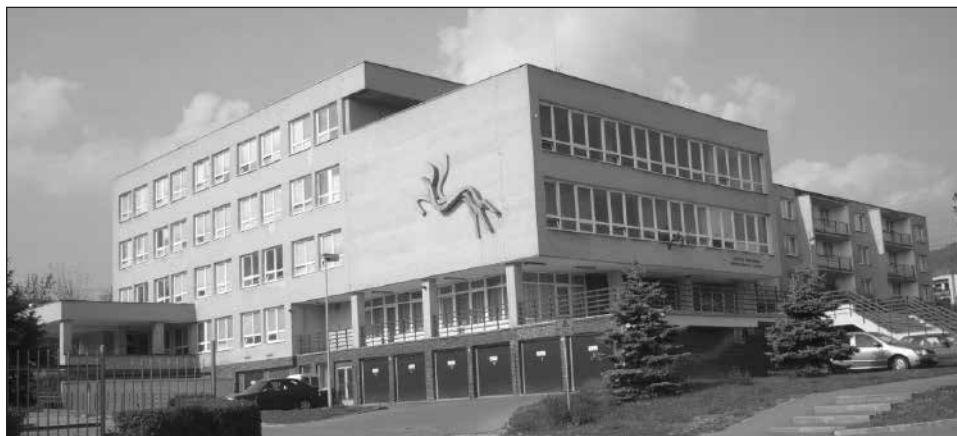
Budova IVVL Košice
