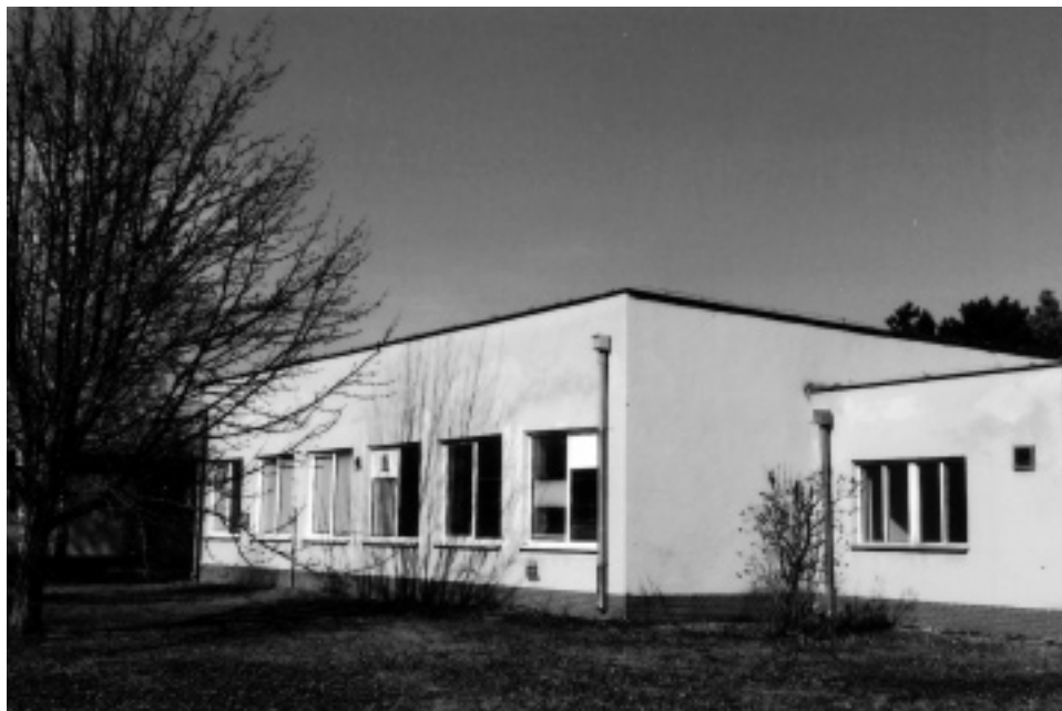
Obr. 18. Pohľad na prevádzkový trakt veterinárnej nemocnice. Vo vystupujúcom objekte sa nachádzali operačné sály.
