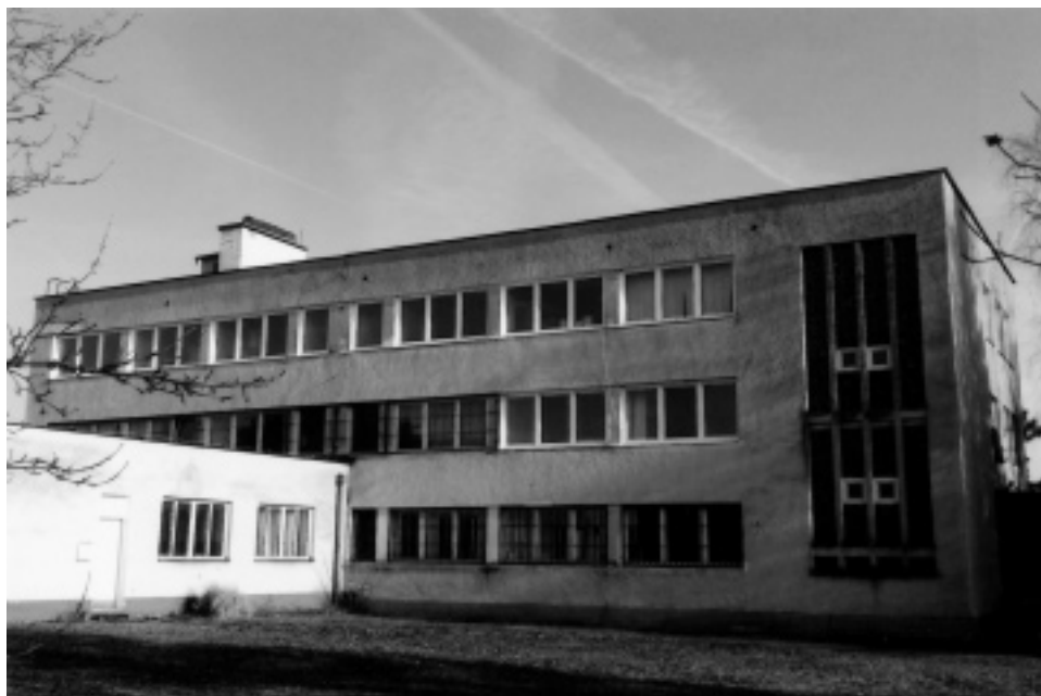
Obr. 17. Budova RVPS v Senici – pohľad z nádvorja areálu.
