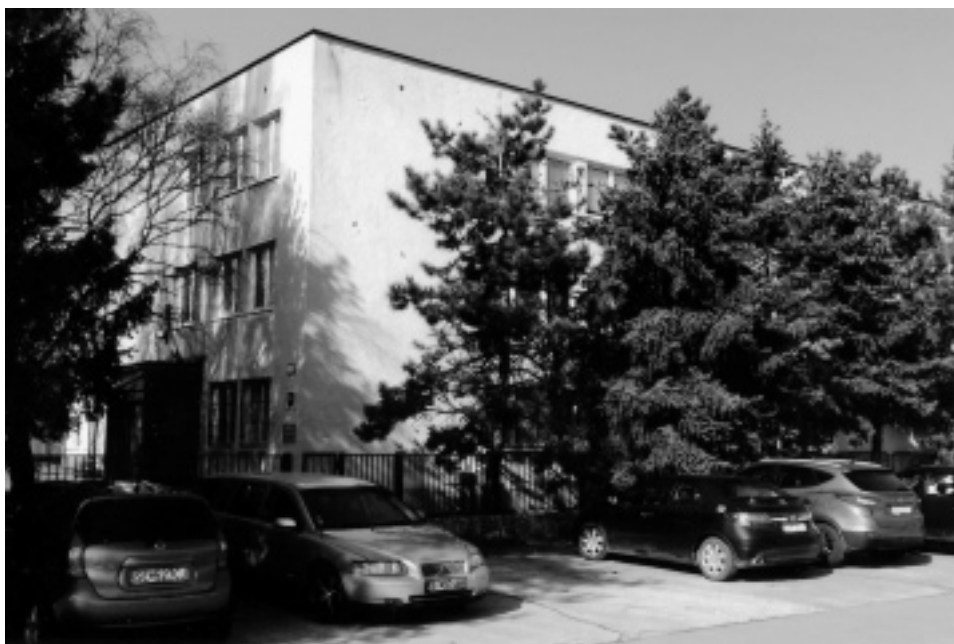
Obr. 16. RVPS v Senici, vstup do hlavnej budovy.
