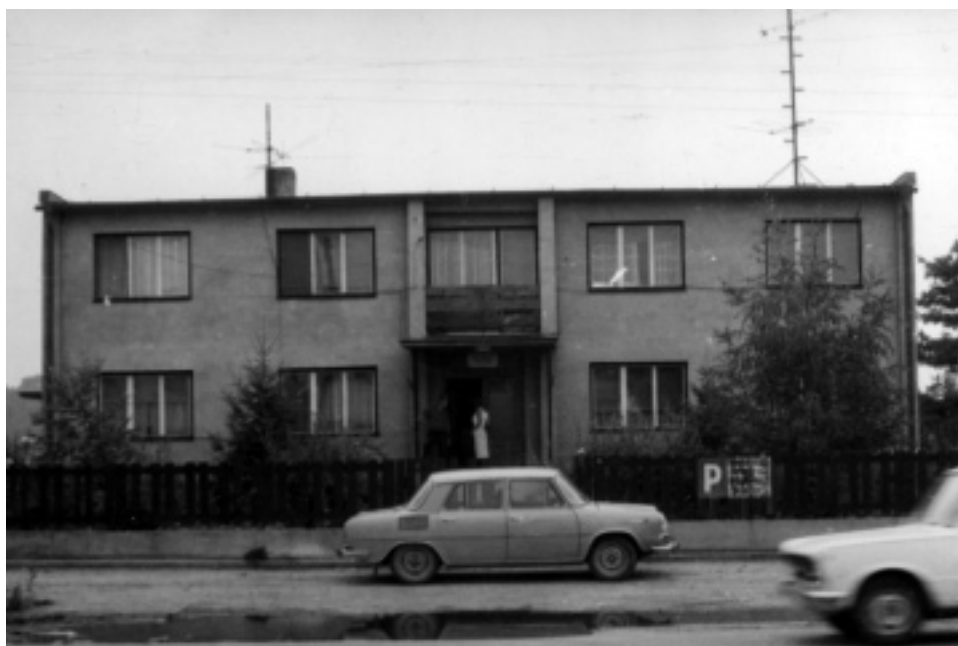
Obr. 14. Budova veterinárneho strediska v Malackách na Perneckej ulici.
