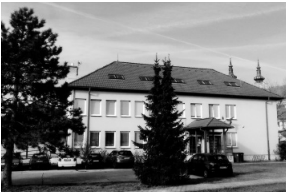
Obr. 19. Bývalá budova veterinárneho strediska v Šaštíne-Strážach (prevádzkovaná v rokoch 1982-1993).
